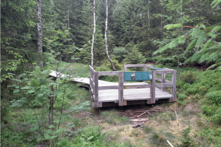
Abb. 17: Ausgetrocknete Schlenke in der Siebensäure, 19.06.2023. Foto: T. Brockhaus.
